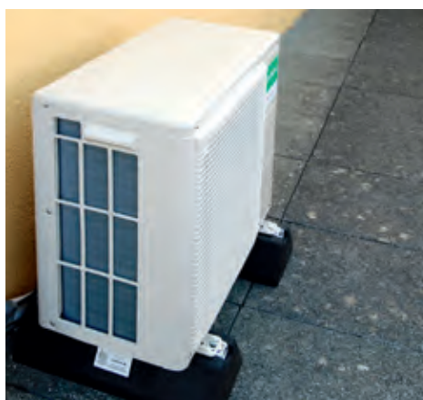
Außeneinheit – Splitanlage
