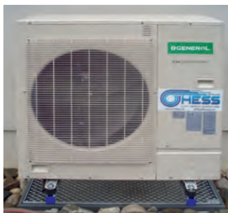
Außeneinheit – Splitanlage
