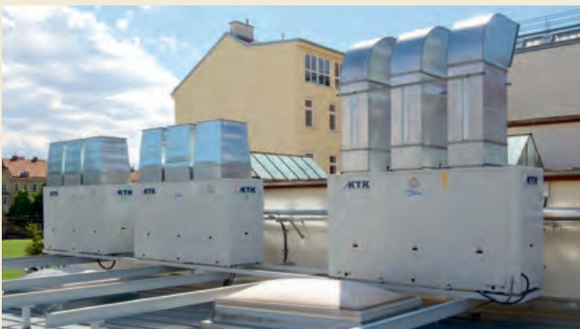
*Kaltwassersätze mit je 150 kW Kühlleistung – Firma EVVA*
