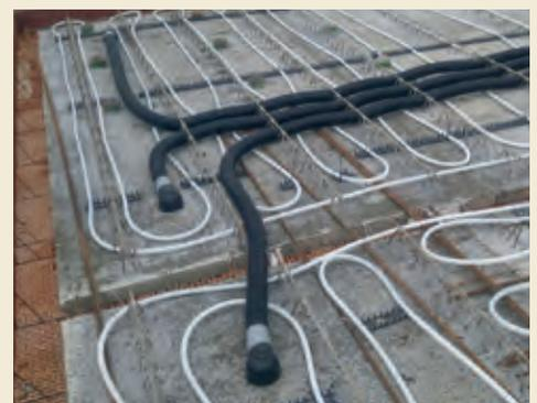
Unsichtbare Luftverteilung im Gebäude in Decken, Wänden und im Bodenaufbau
