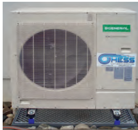
Außeneinheit – Splitanlage
