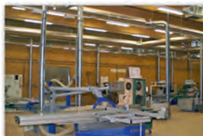
Verrohrung in Halle
