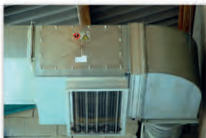
Eco Jet mit Rückluftleitung
