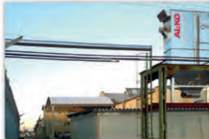
Eco Jet mit Rohrbrücke
