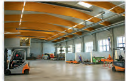
Verrohrung in Halle
