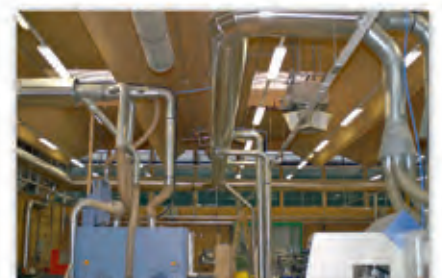
Verrohrung in Halle
