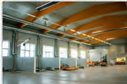
Verrohrung in Halle
